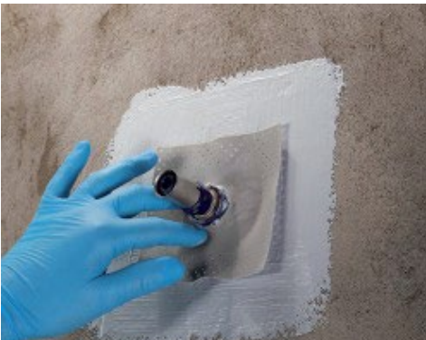
Εφαρμογή σφράγισης Mareband PE 120 για διαμπερείς οπές χρησιμοποιώντας Maregum WPS
