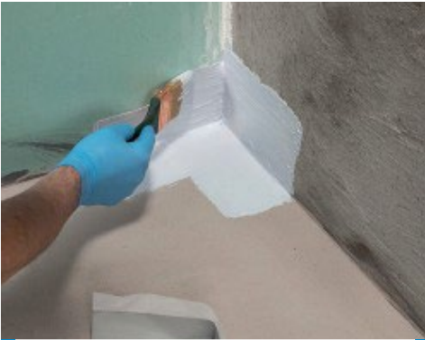
Εφαρμογή γωνιακού τεμαχίου Mareband PE 120 90° με χρήση Maregum WPS
