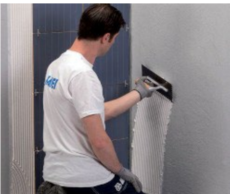
Τοποθέτηση επένδυσης τοίχου με Keralex Maxi S1
