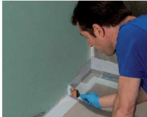
Εφαρμογή του Mareband PE 120 με χρήση Maregum WPS
