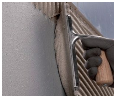
Τοποθέτηση καλύμματος δαπέδου με χρήση UI-tramastic III
