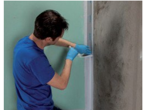
Εφαρμογή του Mareband PE 120 με χρήση Maregum WPS
